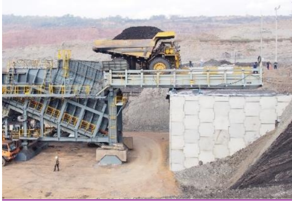
รูปที่ 2 กำแพงกันดินเหล็กเสริมแบกทานที่ทำการศึกษา
