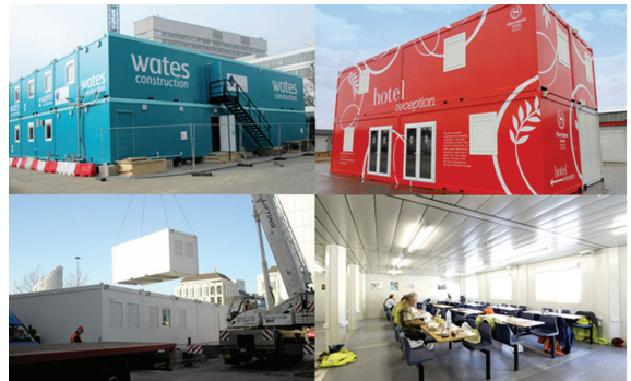
รูปที่ 4 อาคารสำนักงานสำเร็จรูปที่ประกอบจากโมดูล [2]
