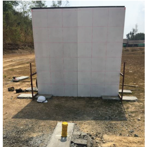
รูปที่ 2 การติดตั้งฉากรับสะเก็ดระเบิดและ Pipe Bomb
