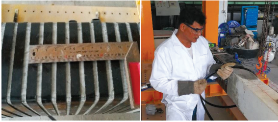
(ก) (ข) รูปที่ 2 การเสริมกำลังคานด้วยวิธี PTMS
