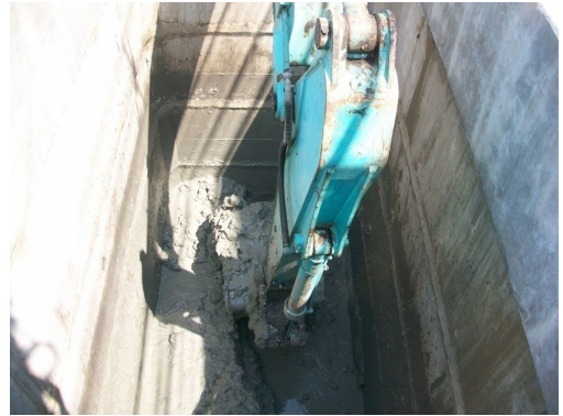
รูปที่ 3 การขุดดินภายในบ่อพักออกเพื่อให้บ่อจมน้ำ
