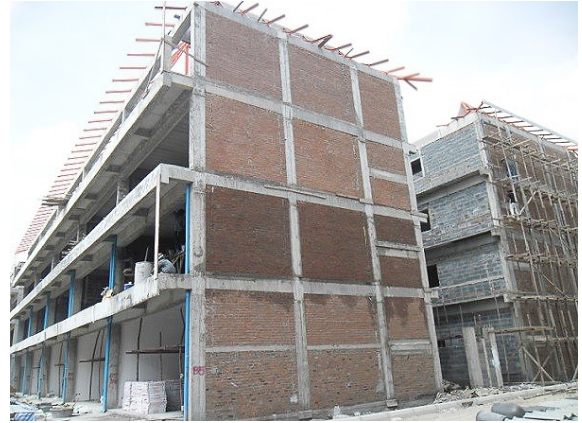
รูปที่ 4 พื้นที่ในการทำงานฉาบปูนผนังภายนอกอาคาร
