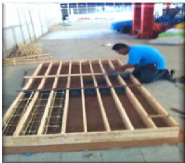
รูปที่ 1 ไม้ไผ่ใช้แทนเหล็กเสริม
