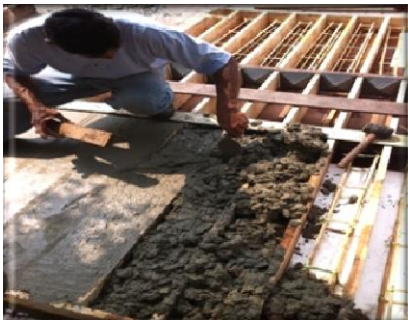
รูปที่ 4 หล่อตัวอย่างคอนกรีต
