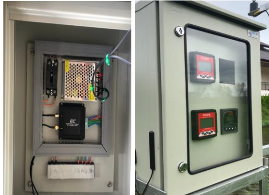
รูปที่ 4 อุปกรณ์สำหรับการติดตามผลแบบเรียลไทม์ในพื้นที่นาข้าว
