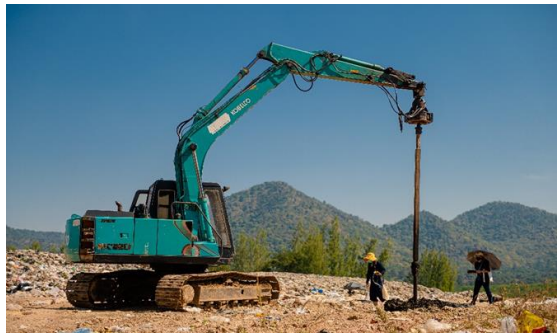
รูปที่ 2 การใช้รถขุดเจาะเพื่อวิเคราะห์ปริมาณขยะมูลฝอยเก่าภายในบ่อขยะ
