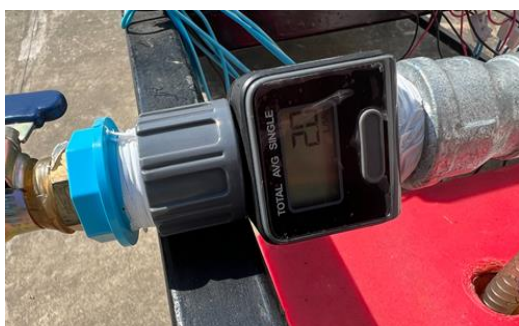
รูปที่ 7 ติดตั้งเครื่องวัดอัตราการไหลที่ทางออกของ น้ำร้อนตัวเก็บรังสีอาทิตย์
