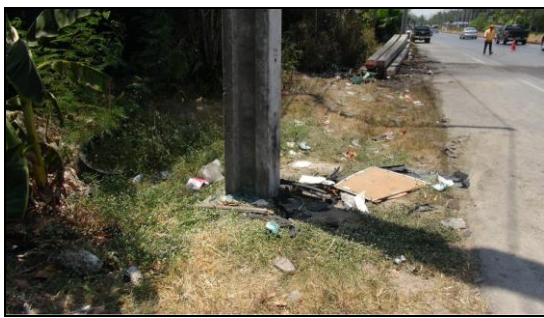
รูปที่ 11 เสาไฟฟ้าที่เกิดเหตุ
