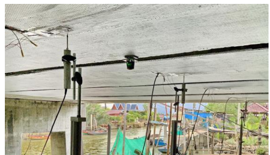
รูปที่ 4 การติดตั้งอุปกรณ์ตรวจวัดสะพานใต้แผ่นดินสะพาน
