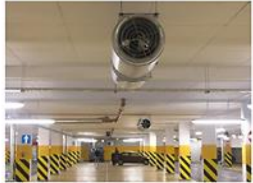
รูปที่ 17 ตัวอย่างพัดลมที่ใช้ช่วยในการไหลเวียนของอากาศ
