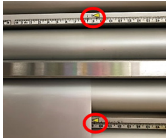
รูปที่ 16 การติดสัญลักษณ์บริเวณจุดต่อพอยล์
